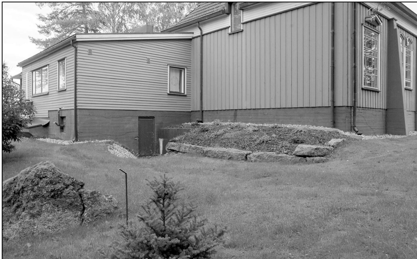
Kirkon seinänvierukset siistittiin ja sadevedet johdettiin pois seinänvierustalta.
