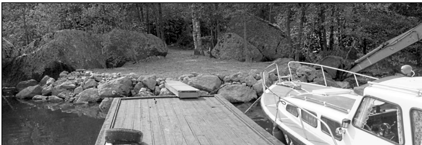
Kivistä koottu rantapengerryks on tarpeen, jottei hiekkainen tasanne huuhtoudu korkeammilla vesillä mereen.
