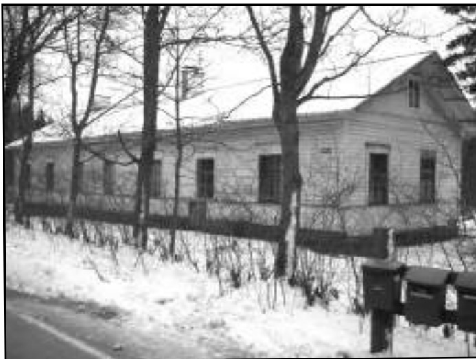
Uutela, jossa Koukin kestikievari oli vv. 1874-1920. Nykyinen tien vieressä oleva rakennus on vuodelta 1892.
