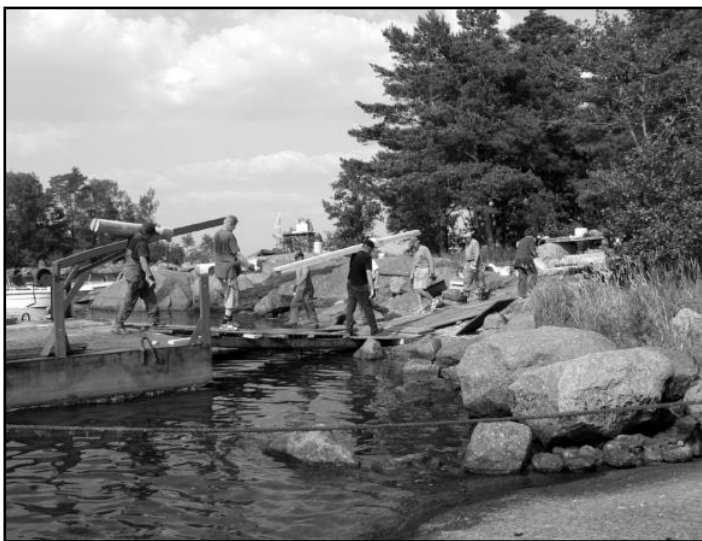
Saarella ei ollut koneita vaan kaikki tarvikkeet jouduttiin kantamaan henkilövoimin rantaan ja sieltä edelleen rakennuspaikalle.
